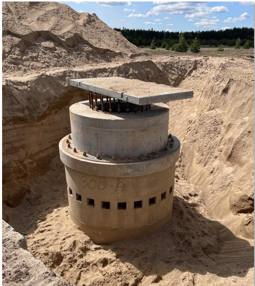
Fundament o średnicy 3.0 m częściowo odkopany na potrzeby badań terenowych
