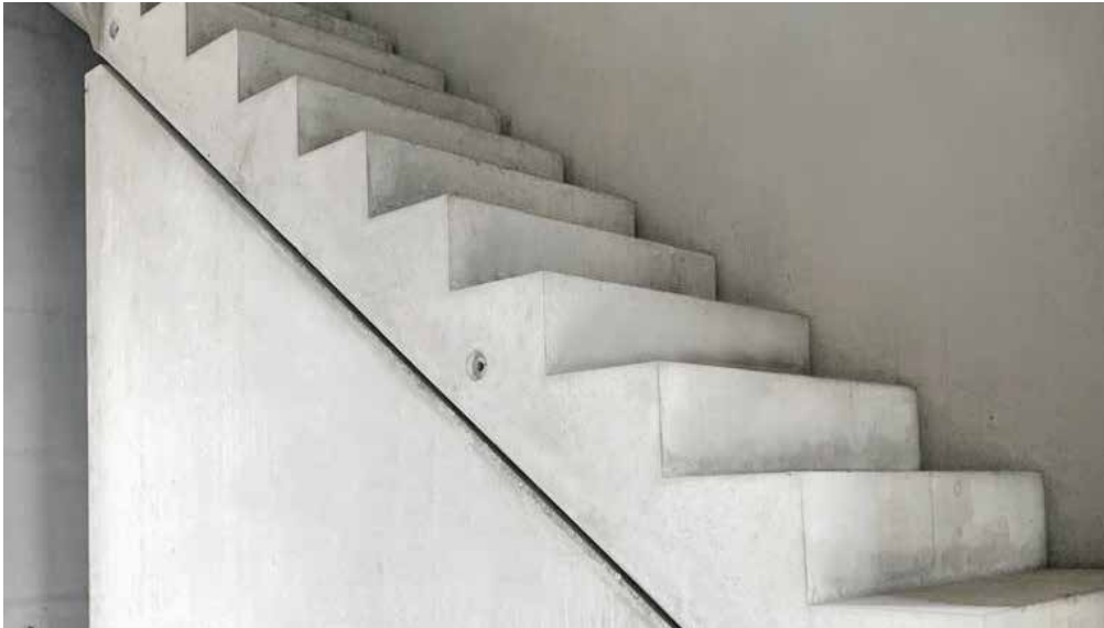
Schody prefabrykowane w inwestycji o zabudowie szeregowej
