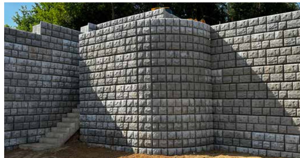
Ściana zabezpieczająca nierówność terenu zbudowana z bloków ozdobnych
