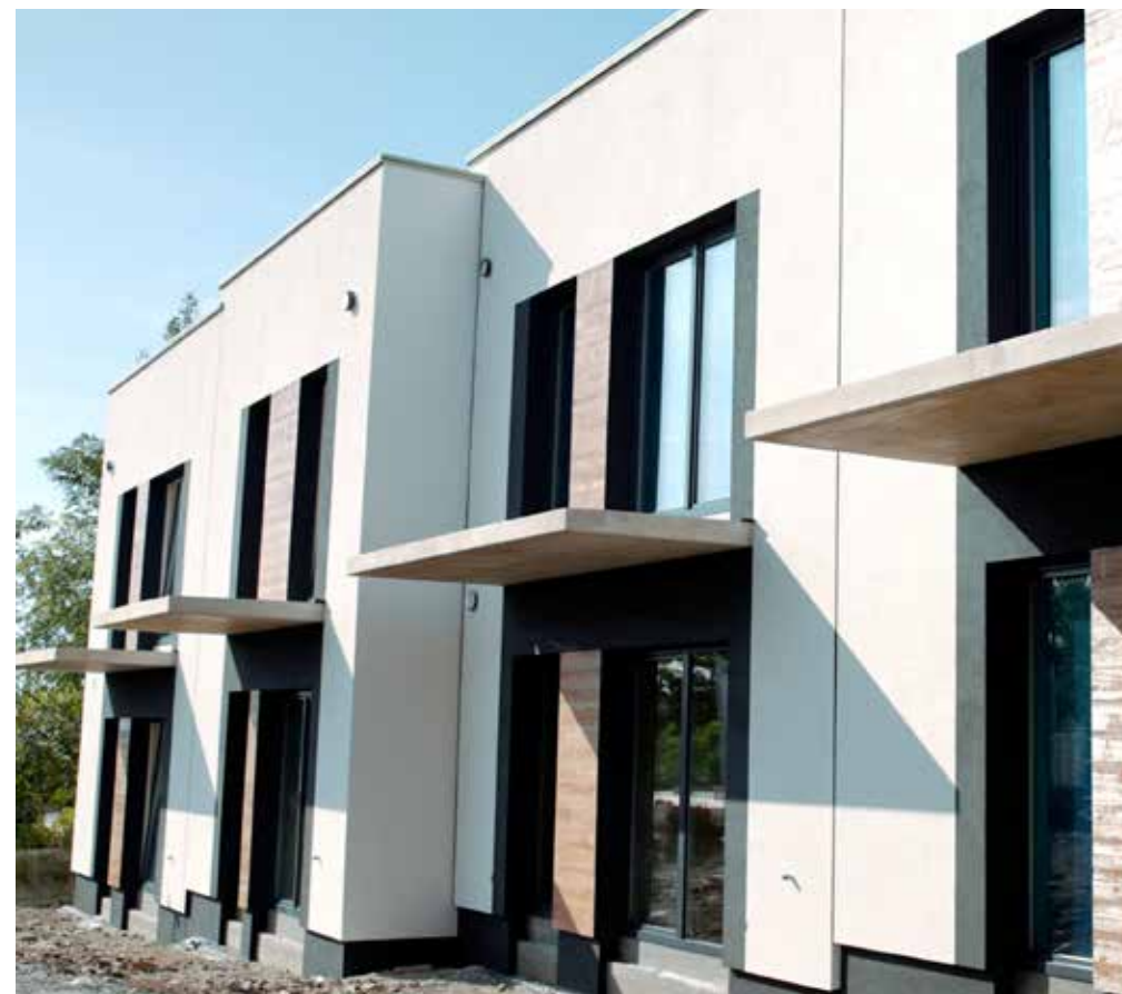
Zamontowane balkony prefabrykowane z łącznikiem termoizolacyjnym
