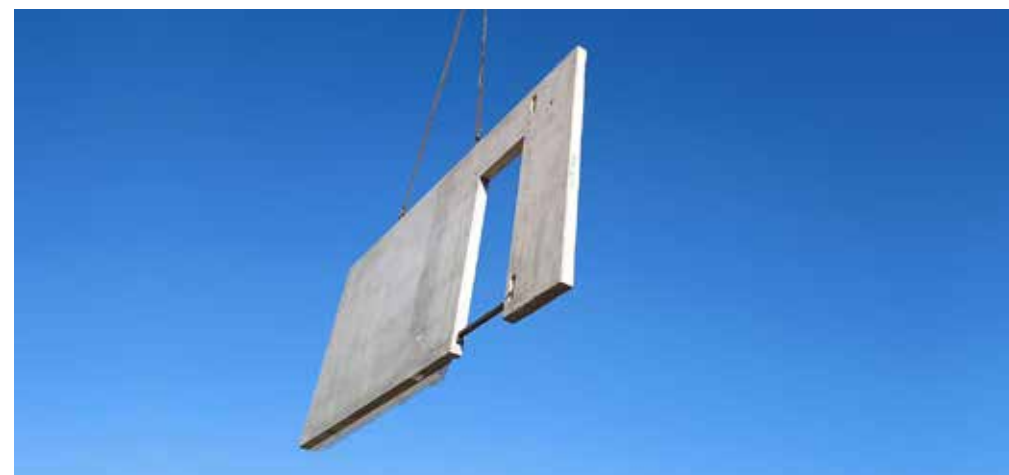
Ściana montowana na budowie za pomocą dźwigu
