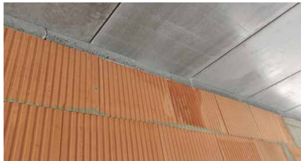
Zastosowanie betonowych podkładek dystansowych pod stropem filigranowym
