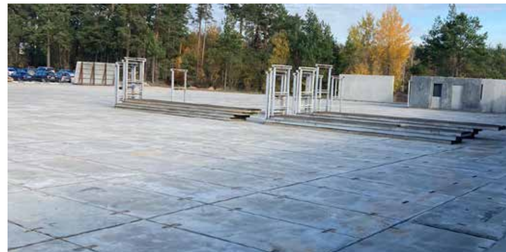
Teren przemysłowy utwardzony płytami drogowymi
