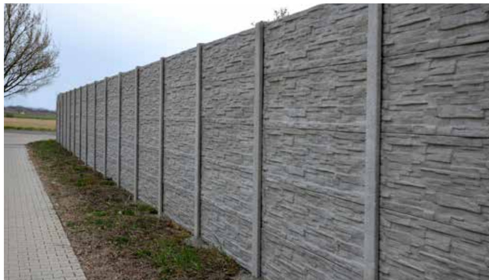
Posesja ogrodzona płotem betonowym
