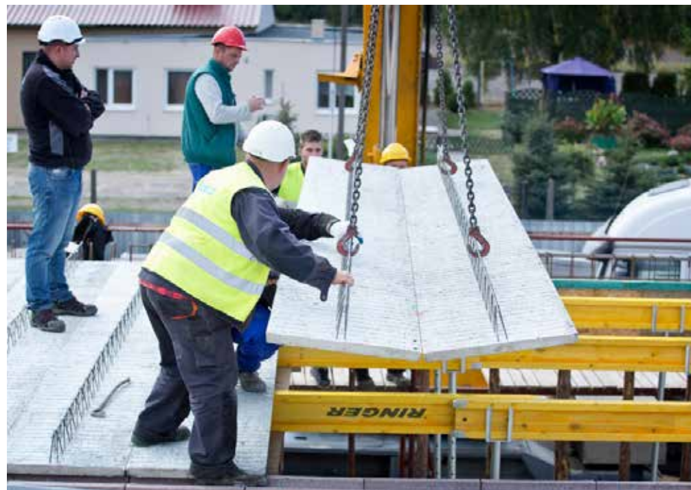
Montaż stropu Vector
