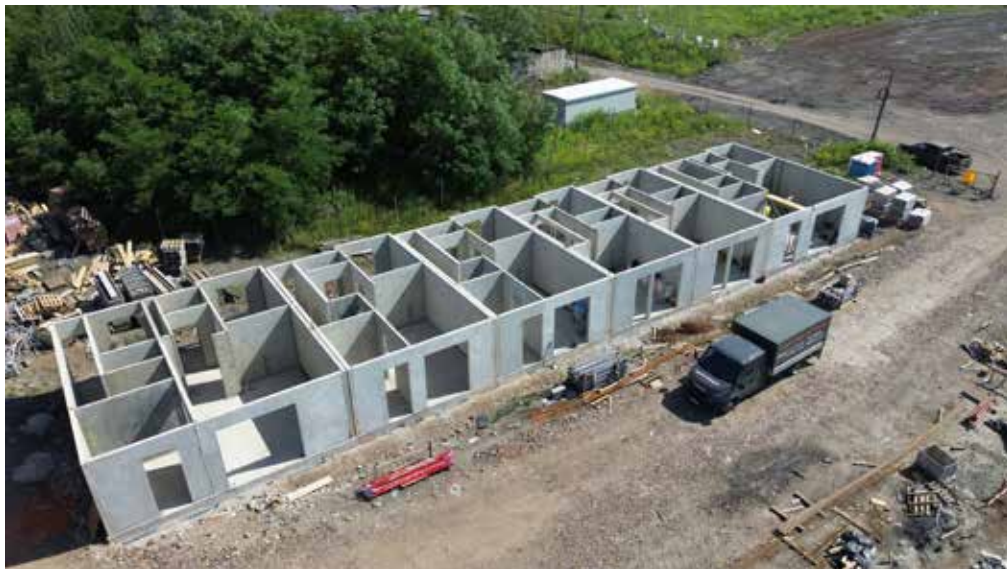
Budynek szeregowy stawiany ze ścian prefabrykowanych
