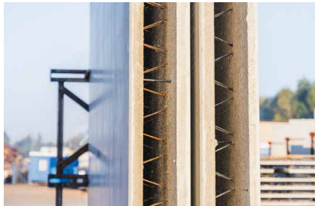
Przekrój ściany zespolonej
