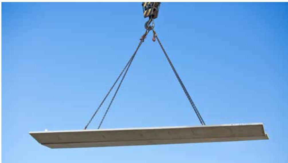
Szybki montaż płyt za pomocą dźwigu HDS
