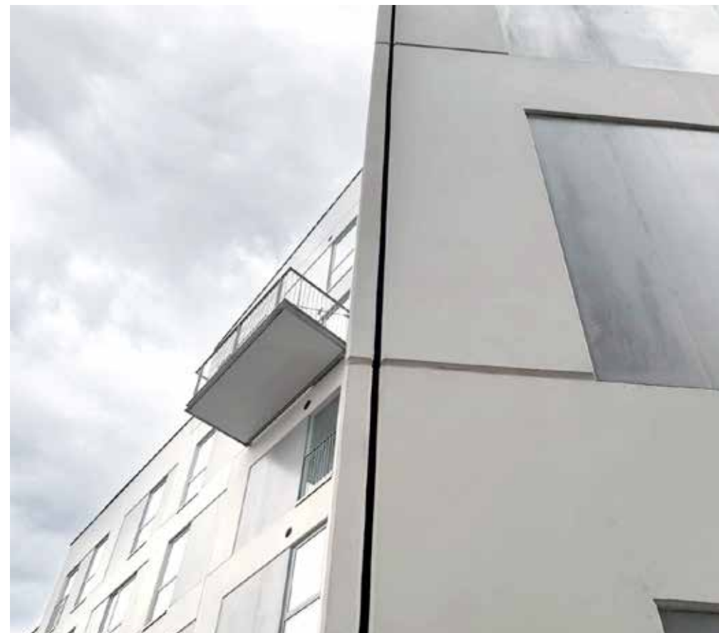
Budynek postawiony ze ścian prefabrykowanych trójwarstwowych
