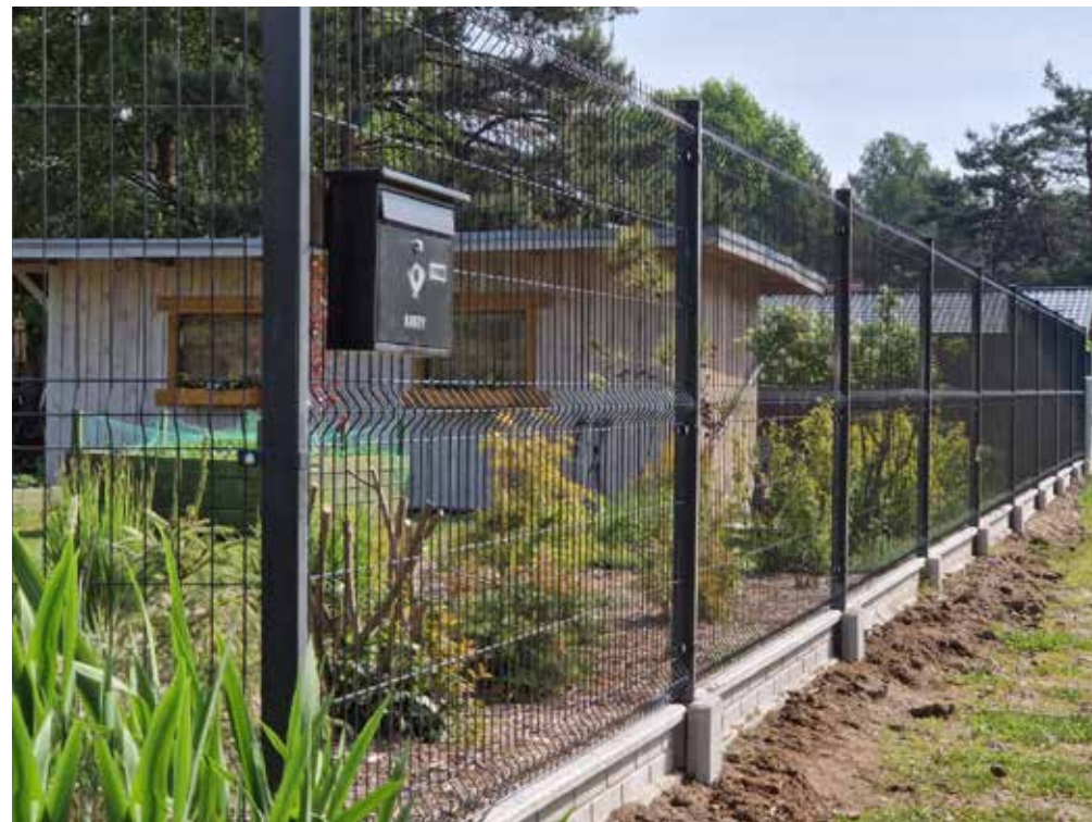
Ogrodzenie postawione z wykorzystaniem podmurówek prefabrykowanych
