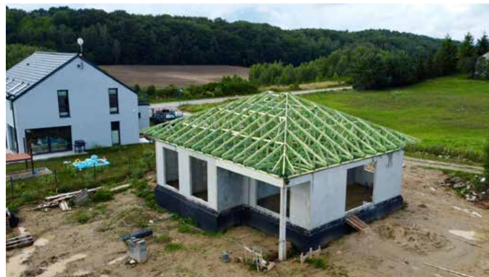
Budowa domu jednorodzinnego ze ścian prefabrykowanych
