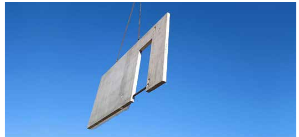
Ściana montowana na budowie za pomocą dźwigu
