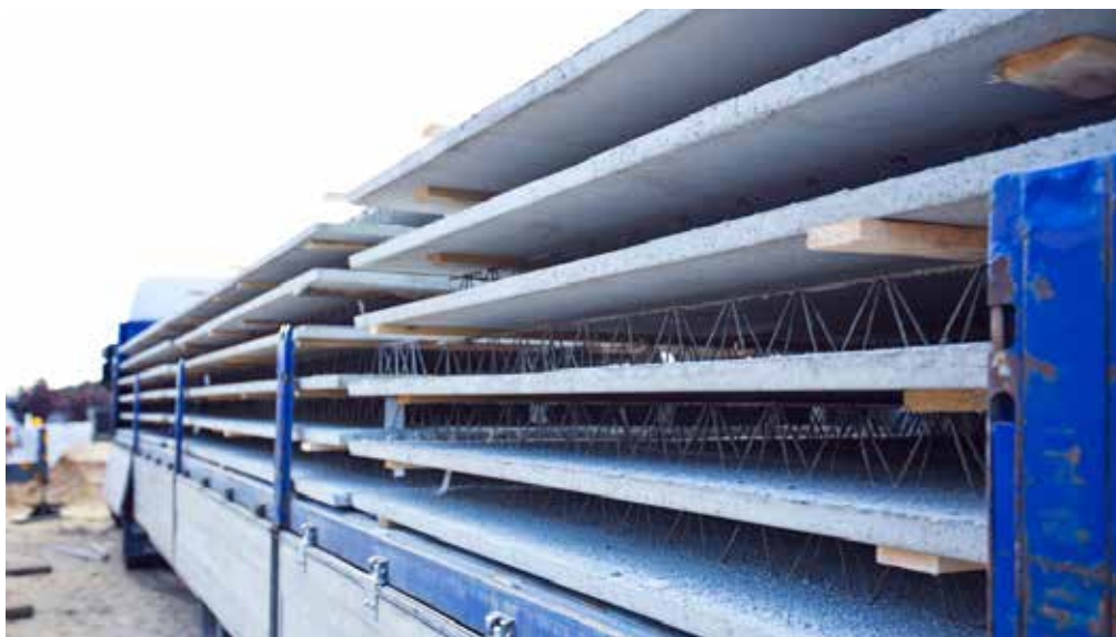
Transport płyt stropowych
