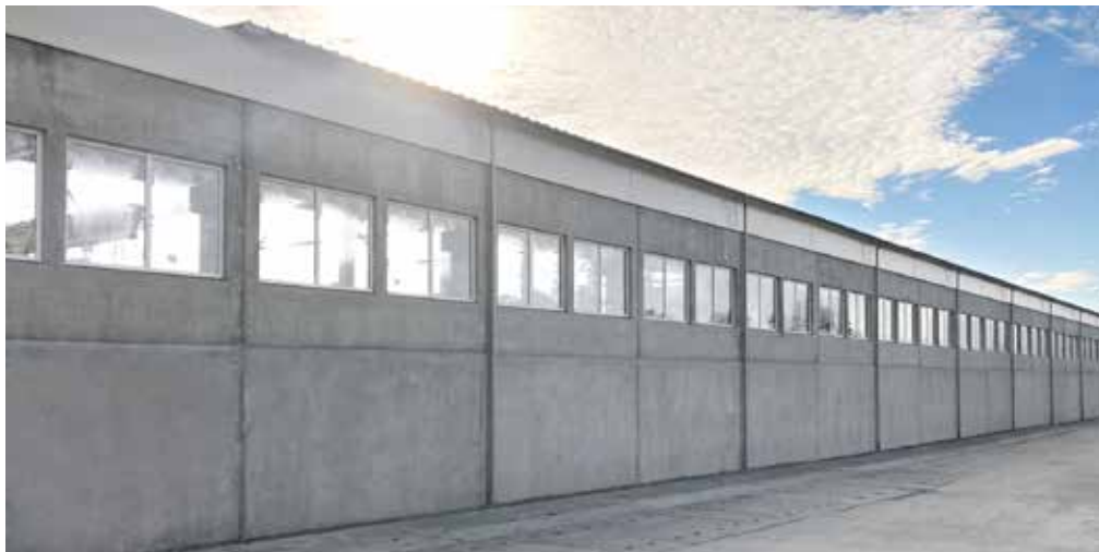
Hala produkcyjna zbudowana ze ścian trójwarstwowych
