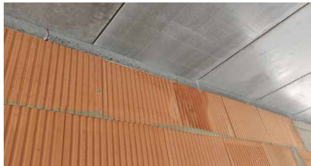
Zastosowanie betonowych podkładek dystansowych pod stropem filigranowym
