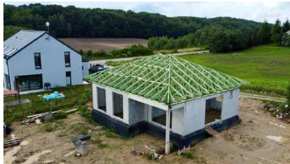
Budowa domu jednorodzinnego ze ścian prefabrykowanych
