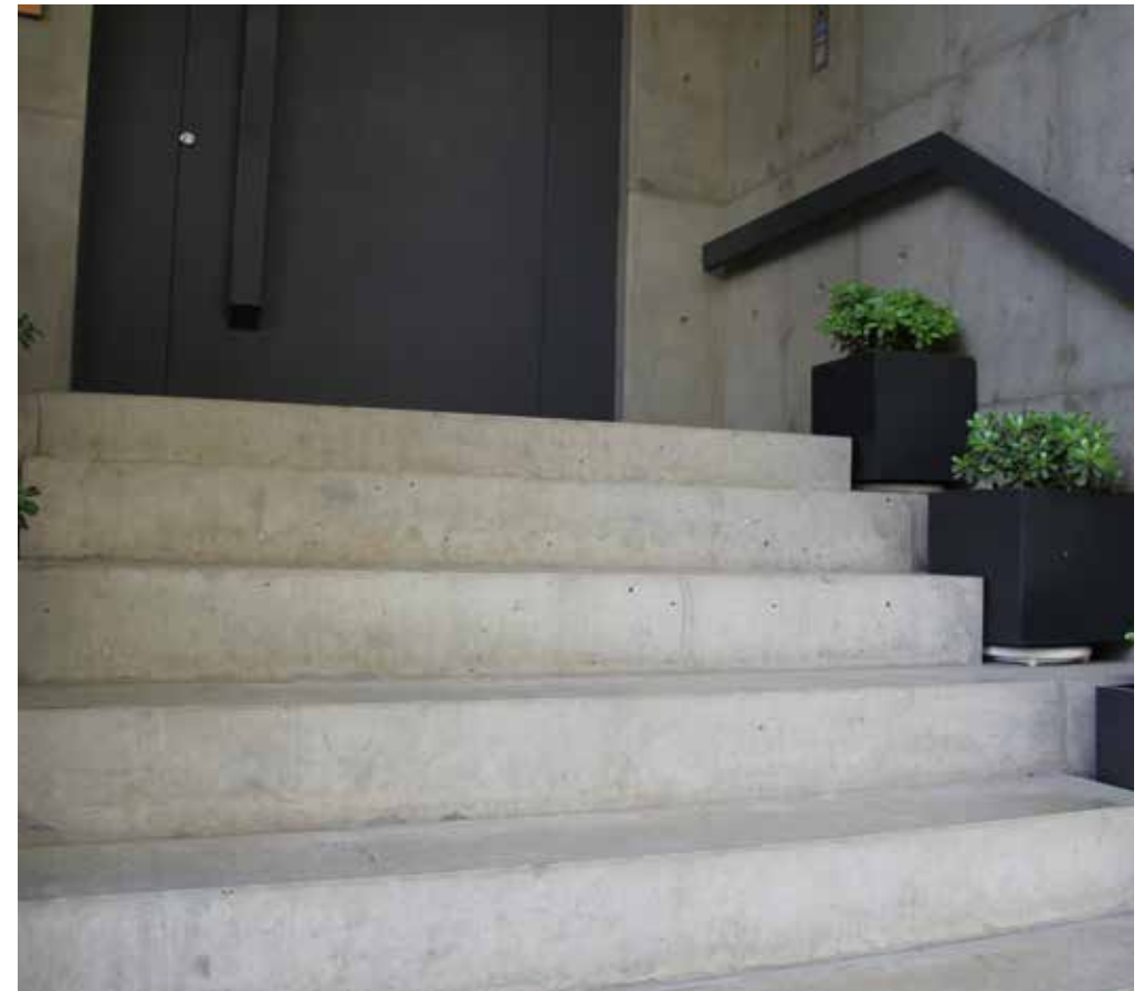
Schody prefabrykowane zewnętrzne
