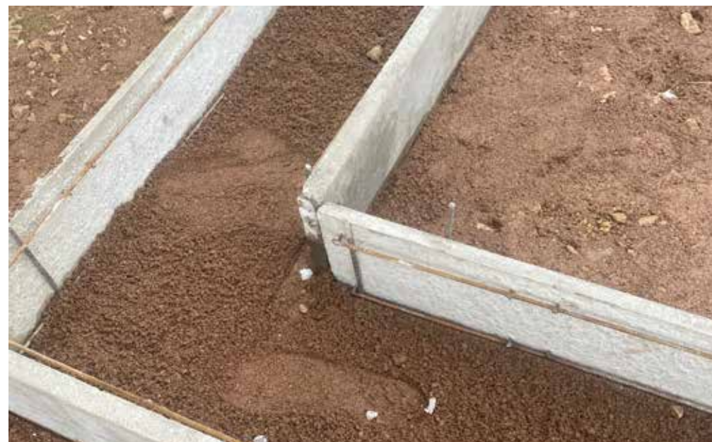
Przykład zastosowania betonowych desek szalunkowych do wykonania fundamentu
