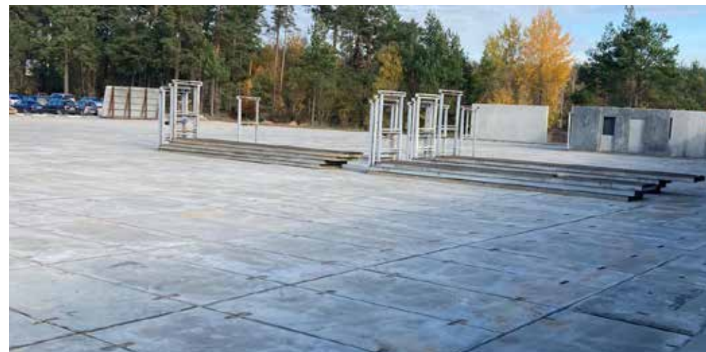
Teren przemysłowy utwardzony płytami drogowymi
