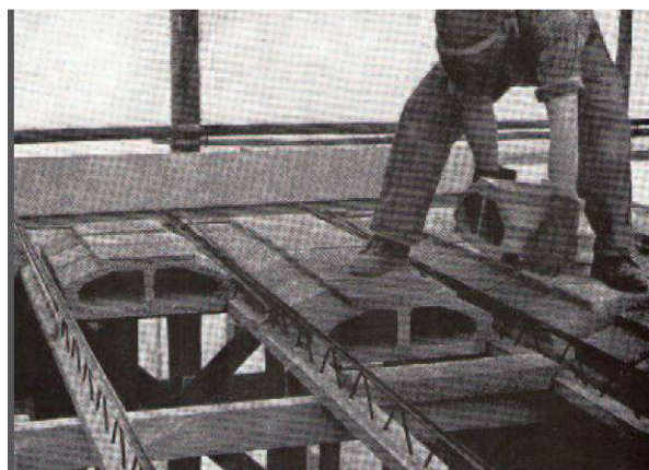
Rys. 3. Pierwsze stropy z belkami kratownicowymi: a) z wypełnieniem z pustaków ceramicznych [32], b) z wypełnieniem z pustaków betonowych [66]
