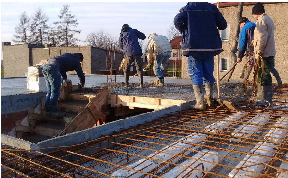
Rys. 63. Układanie mieszanki betonowej na stropie Vector Fig. 65. Laying concrete mixture on the ceiling Vector
