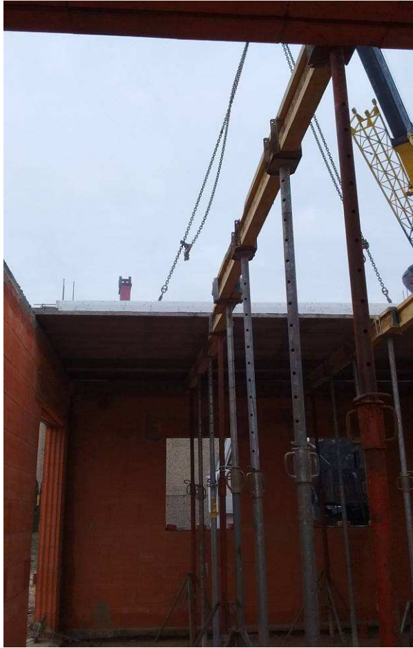
Rys. 32. Podparcie montażowe stropu Vector Fig. 32. Vector ceiling mounting support
