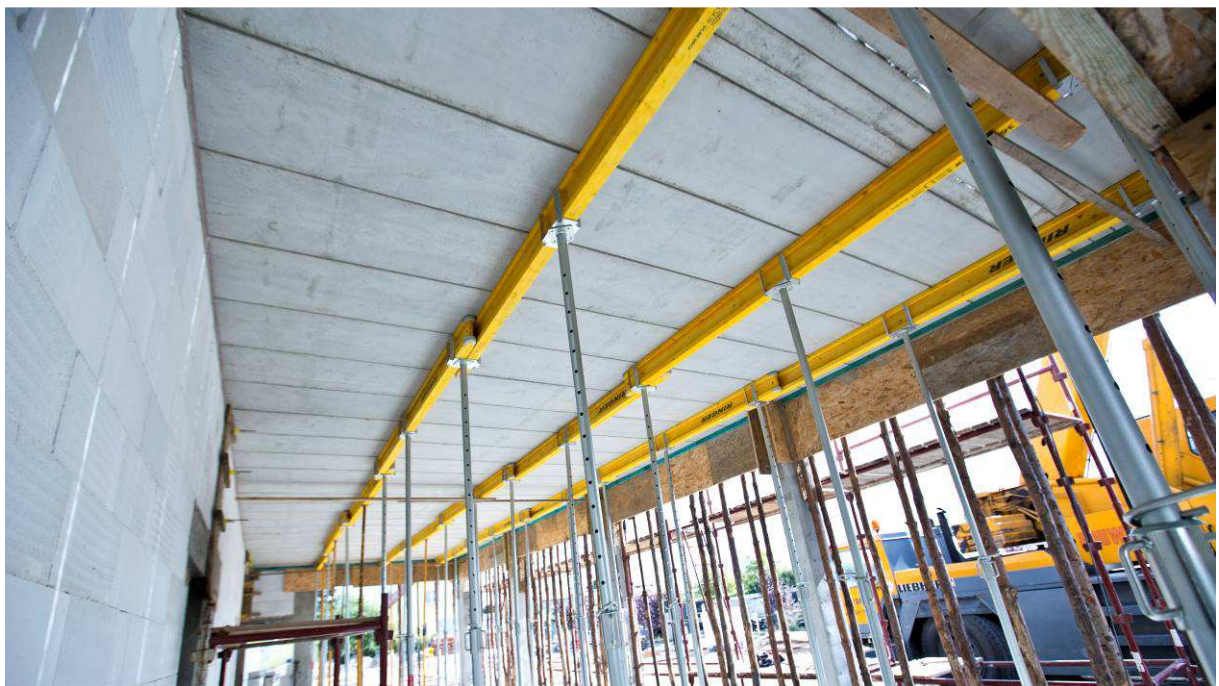
Rys. 33. Podparcie montażowe stropu Vector Fig. 33. Vector ceiling mounting support
