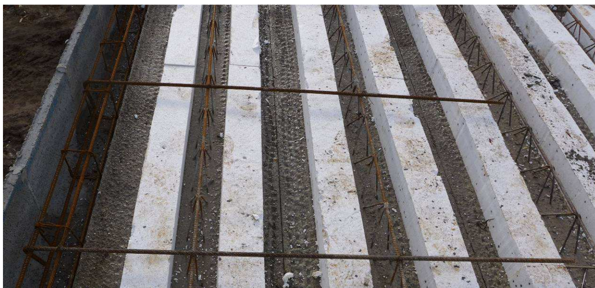
Rys. 44. Dodatkowe zbrojenie przypodporowe Fig. 44. Additional support reinforcement
