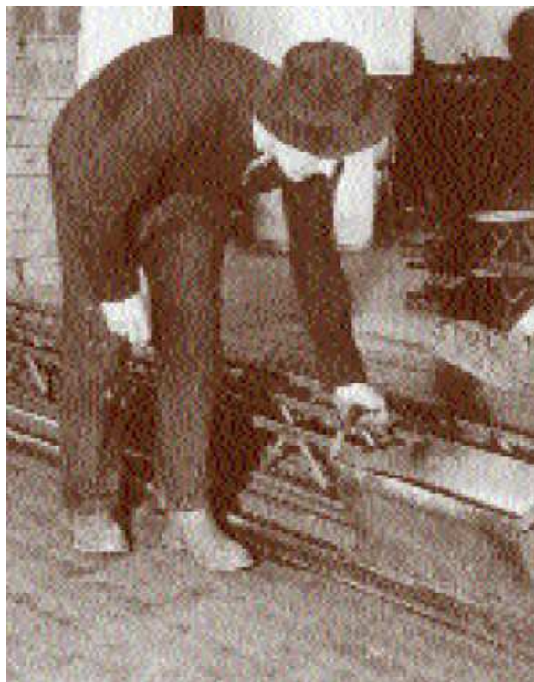
Rys. 2. Produkcja dźwigarów kratownicowych z betonową stopką (1949 r.) [32]
