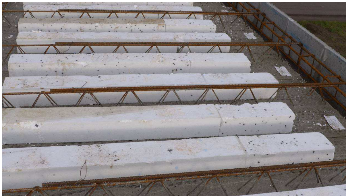
Rys. 43. Dodatkowe zbrojenie przypodporowe Fig. 43. Additional support reinforcement
