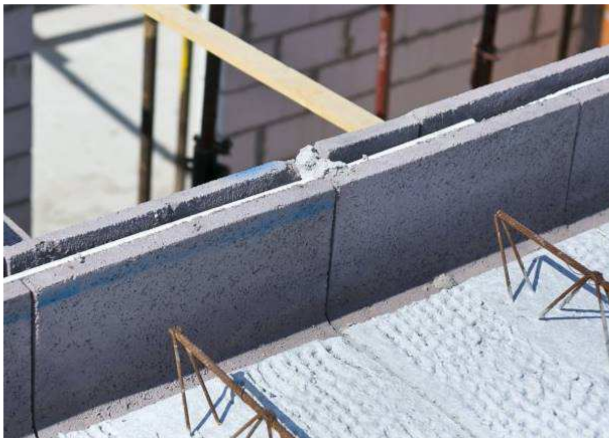
Rys. 27. Oparcie prefabrykatów stropu Vector na zewnętrznej kształtce wieńcowej Fig. 27. Supporting the prefabricated elements of the Vector ceiling on the external ring beam formwork
