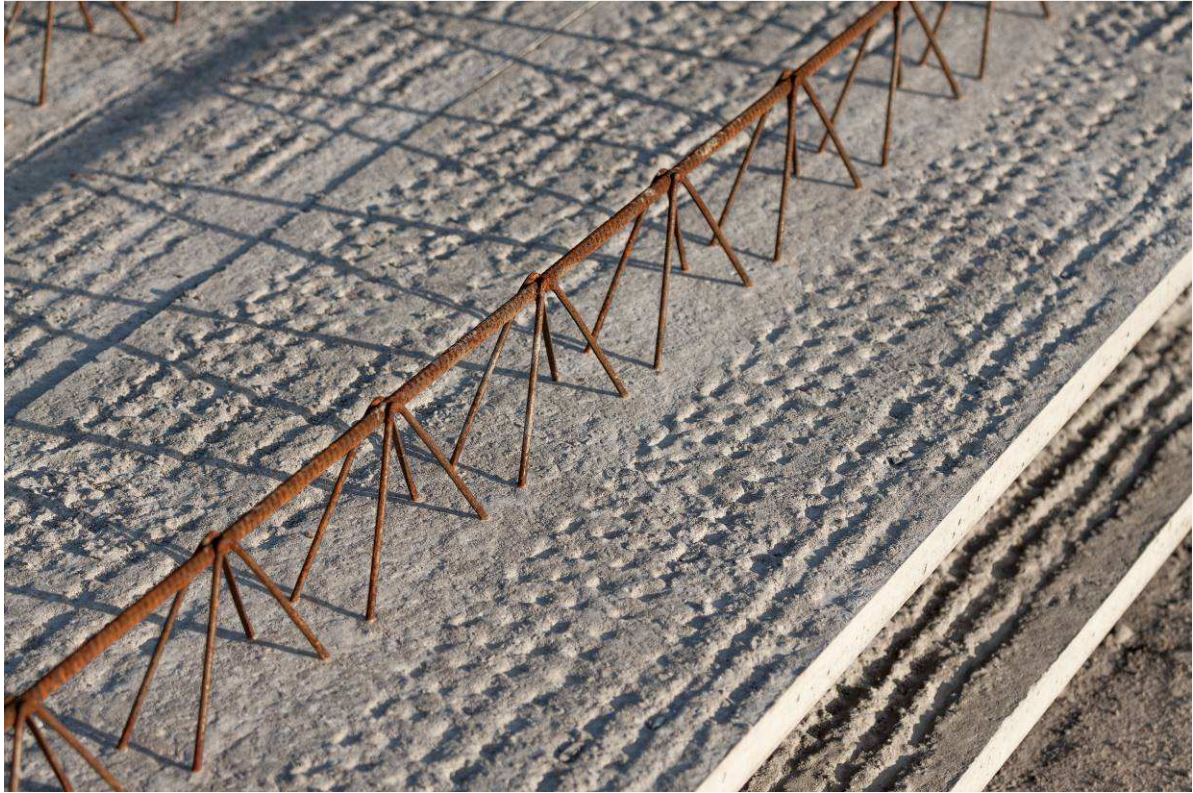
Rys. 11. Płyta stropu Vector Fig. 11. Vector ceiling slab
