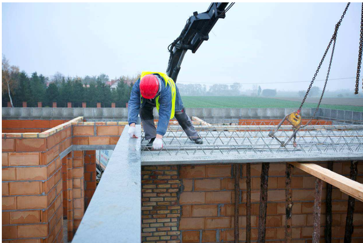
Rys. 31. Montaż płyt stropu Vector na dolnej półce stalowej belki Fig. 31. Installation of Vector ceiling slabs on the bottom shelf of the steel beam
