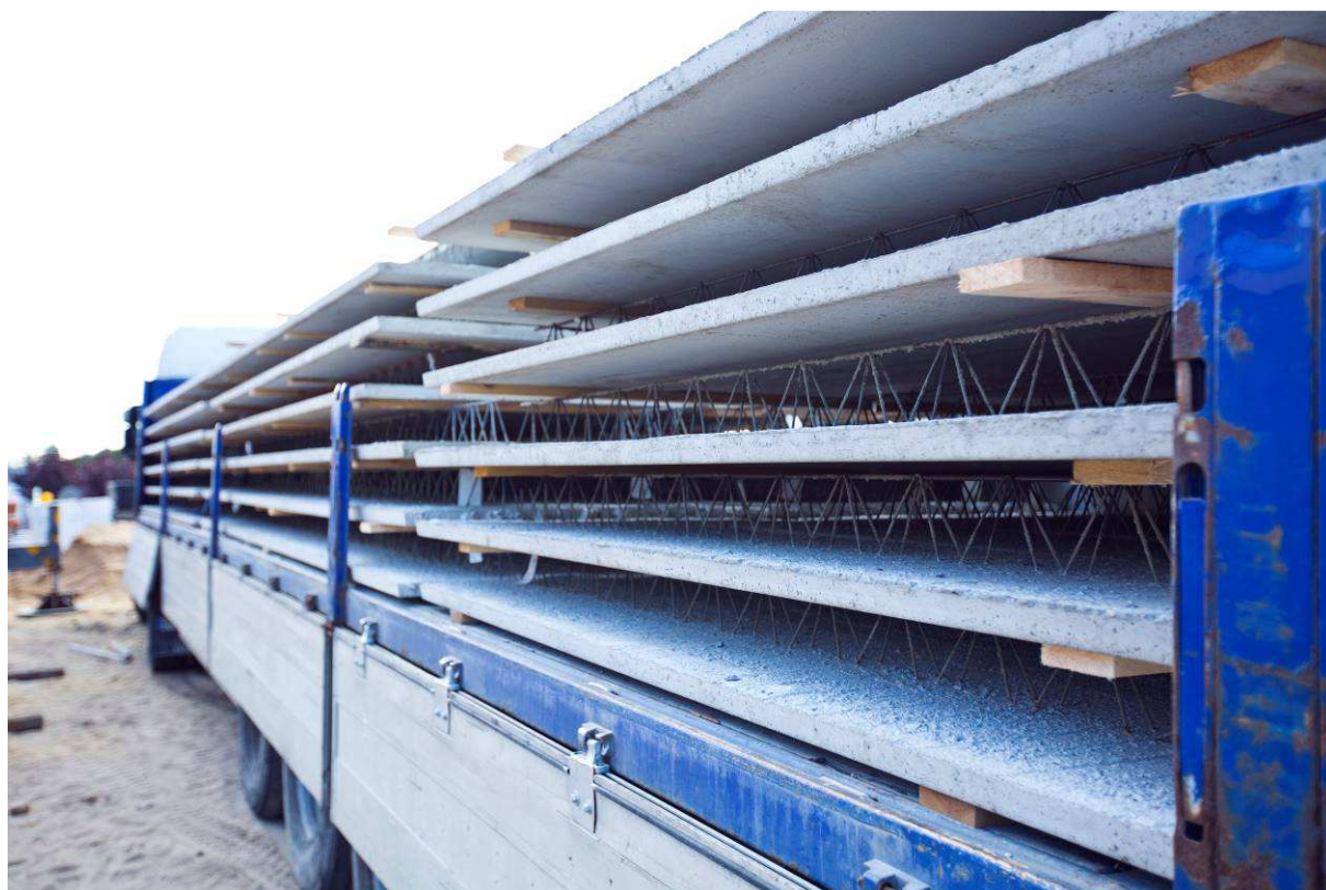
Rys. 20. Prefabrykaty stropu Vector na samochodzie Fig 20. Prefabricated Vector slabs on the car
