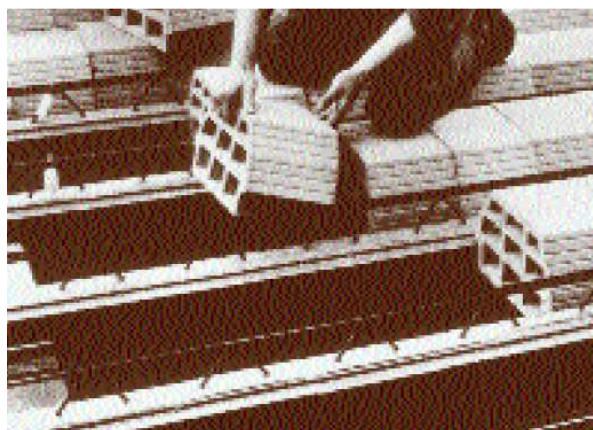
Rys. 3. Pierwsze stropy z belkami kratownicowymi: a) z wypełnieniem z pustaków ceramicznych [32], b) z wypełnieniem z pustaków betonowych [66]
