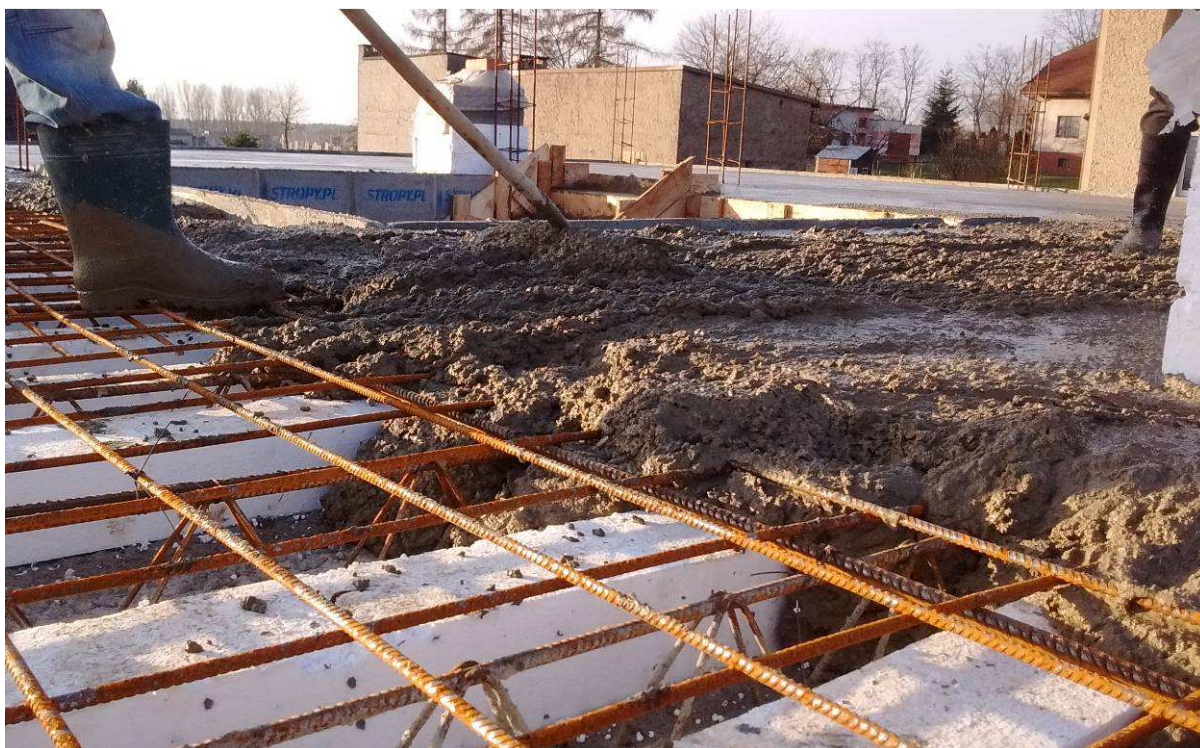
Rys. 64. Układanie mieszanki betonowej na stropie Vector Fig. 66. Laying concrete mixture on the ceiling Vector
