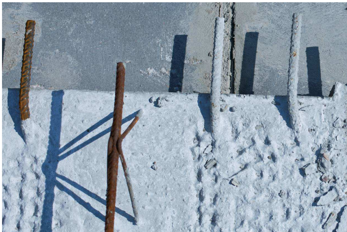
Rys. 53. Widok zbrojenia wypuszczonego z górnej powierzchni płyty stropu Vector Fig. 53. View of the reinforcement released from the upper surface of the Vector slab
