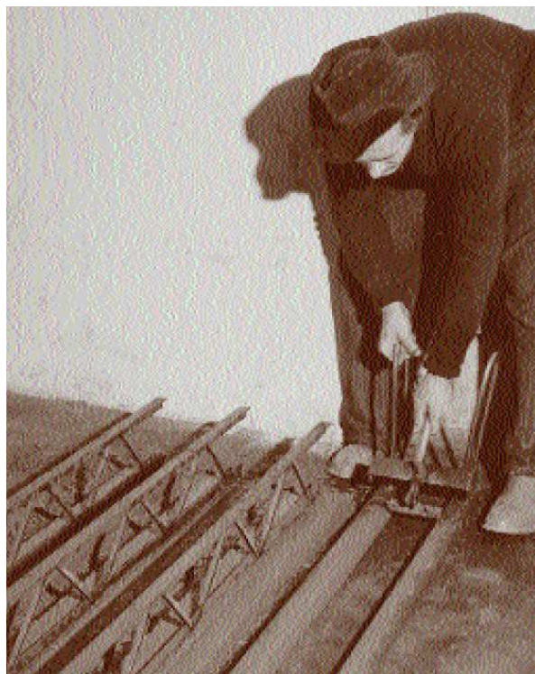
Rys. 2. Produkcja dźwigarów kratownicowych z betonową stopką (1949 r.) [32]
