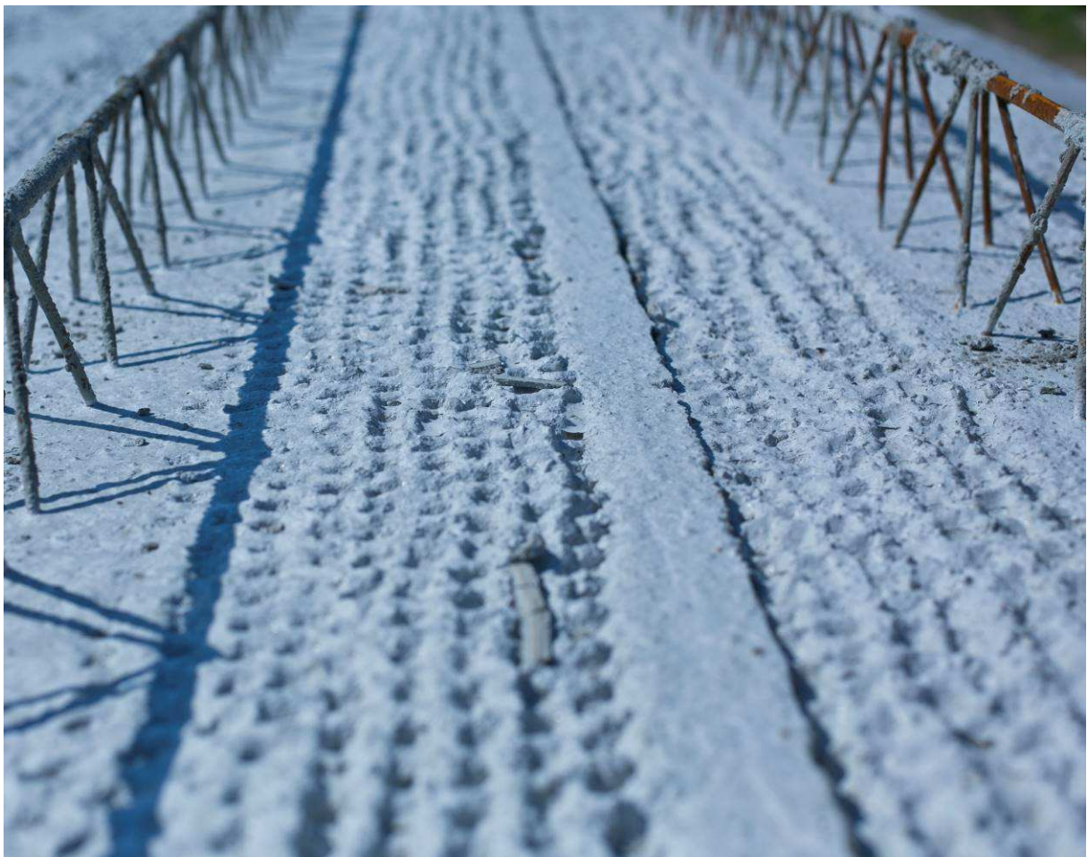
Rys. 16. Przygotowanie powierzchni stropu Vector Fig. 16. Preparation of the Vector slab surface
