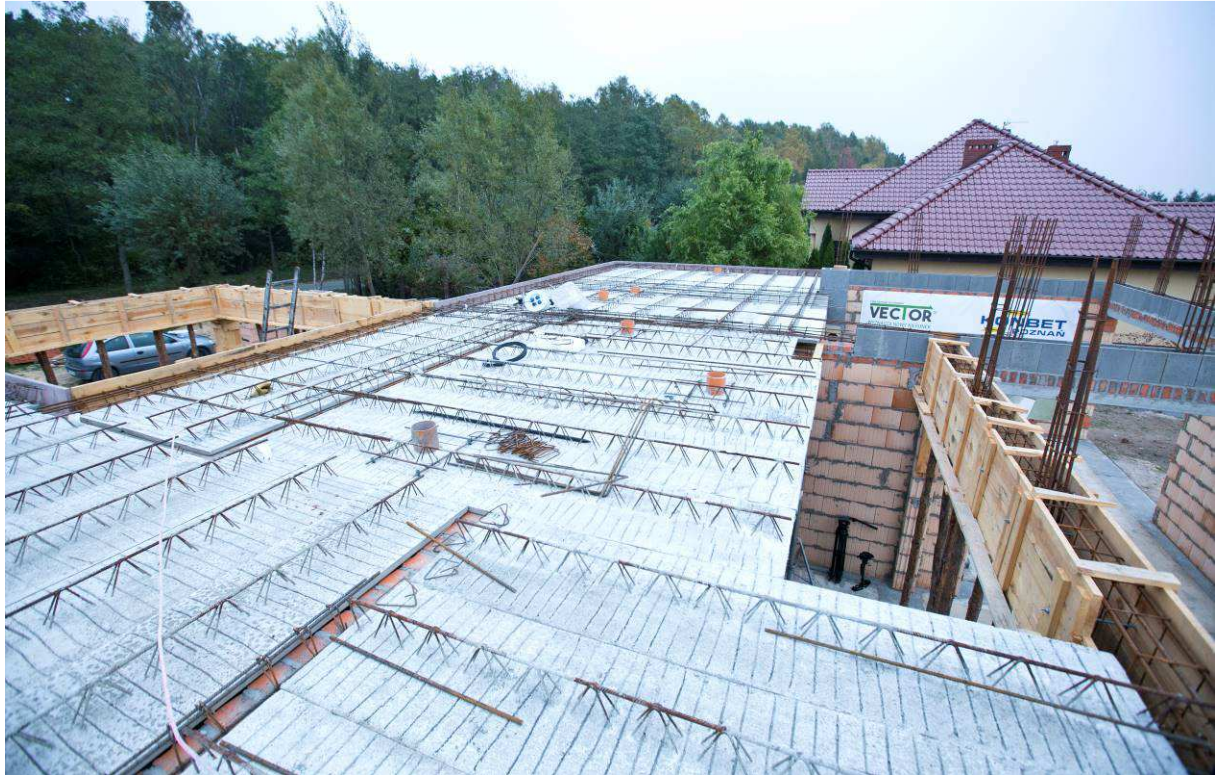
Rys. 9. Pierwsza realizacja stropu Vector – październik 2015 r. Fig. 9. The first implementation of the Vector ceiling – October 2015
