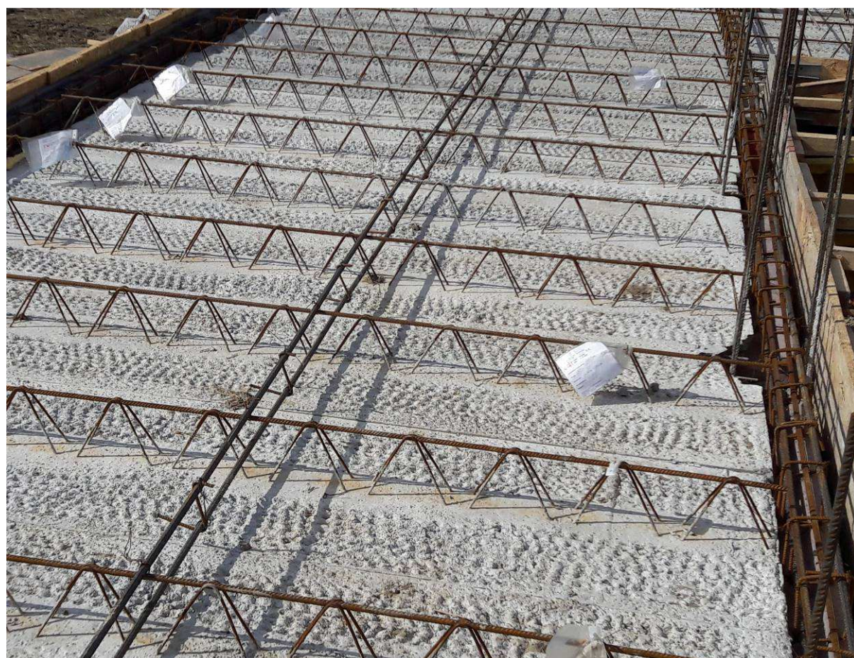
Rys. 41. Żebra rozdzielcze ułożone na prefabrykatach stropu Vector Fig. 41. Distribution ribs arranged on the precast slab of Vector ceiling
