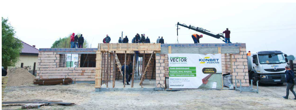
Rys. 8. Pierwsza realizacja stropu Vector – październik 2015 r.
