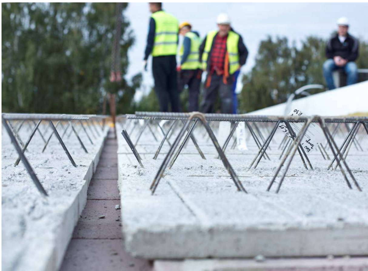
Rys. 28. Oparcie prefabrykatów stropu Vector na wewnętrznej kształtce wieńcowej Fig. 28. Supporting the prefabricated elements of the Vector ceiling on the internal ring beam formwork
