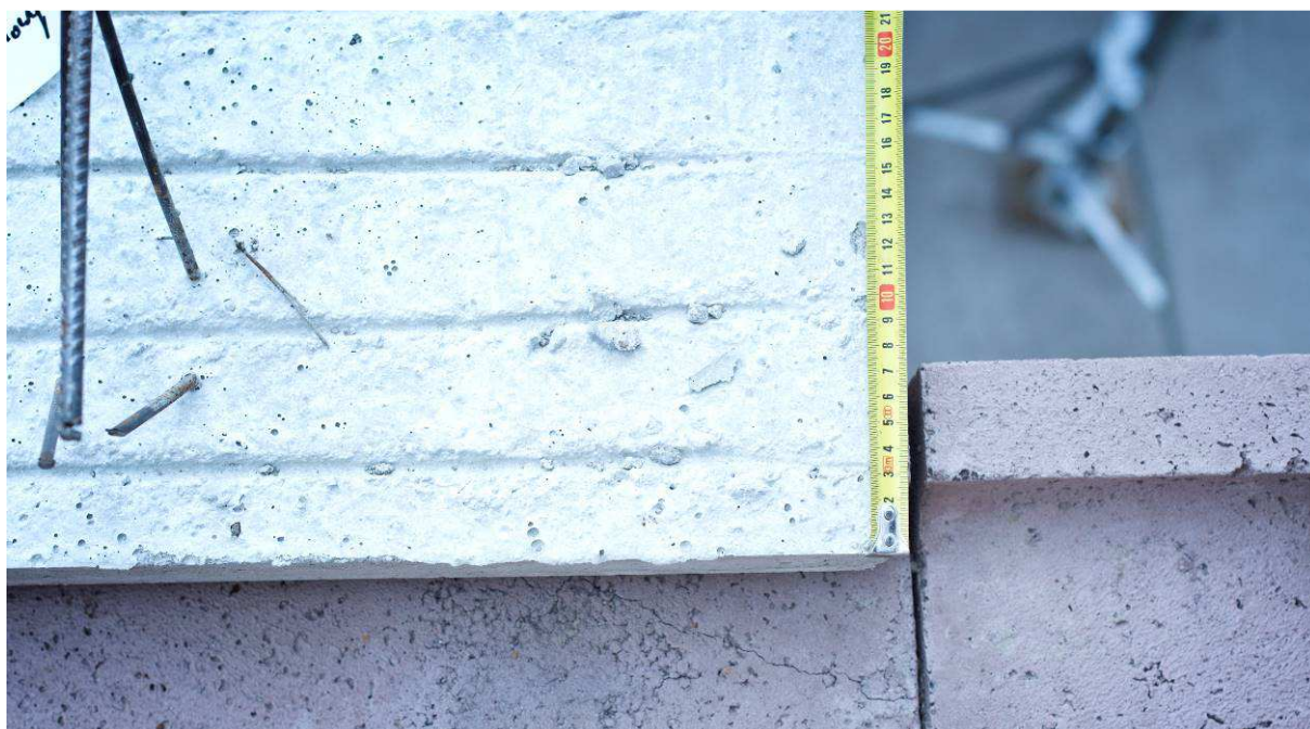
Rys. 29. Pomiar długości oparcia prefabrykatu stropu Vector Fig. 29. Measurement of the support length of the prefabricated Vector slab
