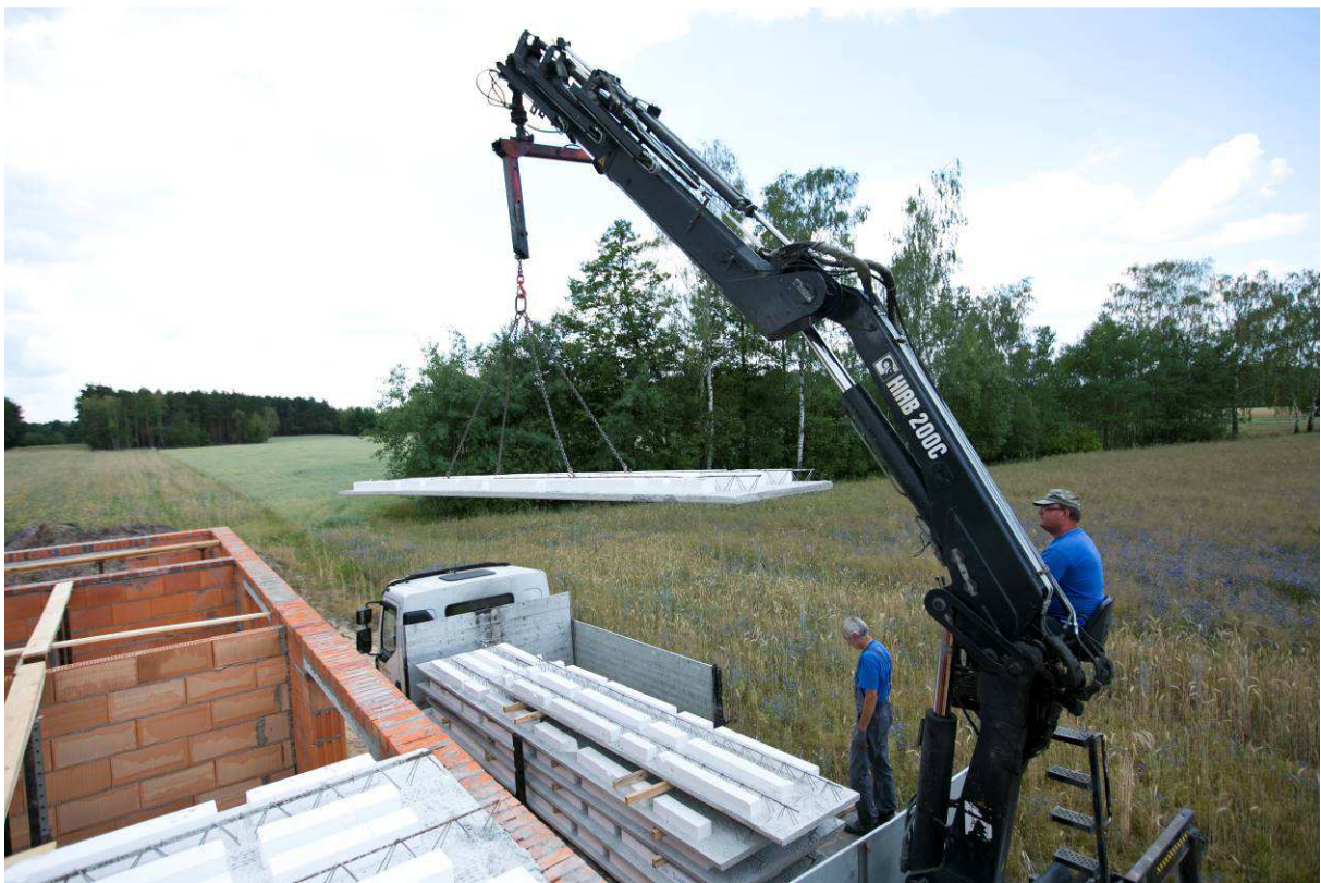
Rys. 24. Montaż płyt stropu Vector za pomocą dźwigu HDS Fig. 24. Installation of Vector slab using a HDS crane
