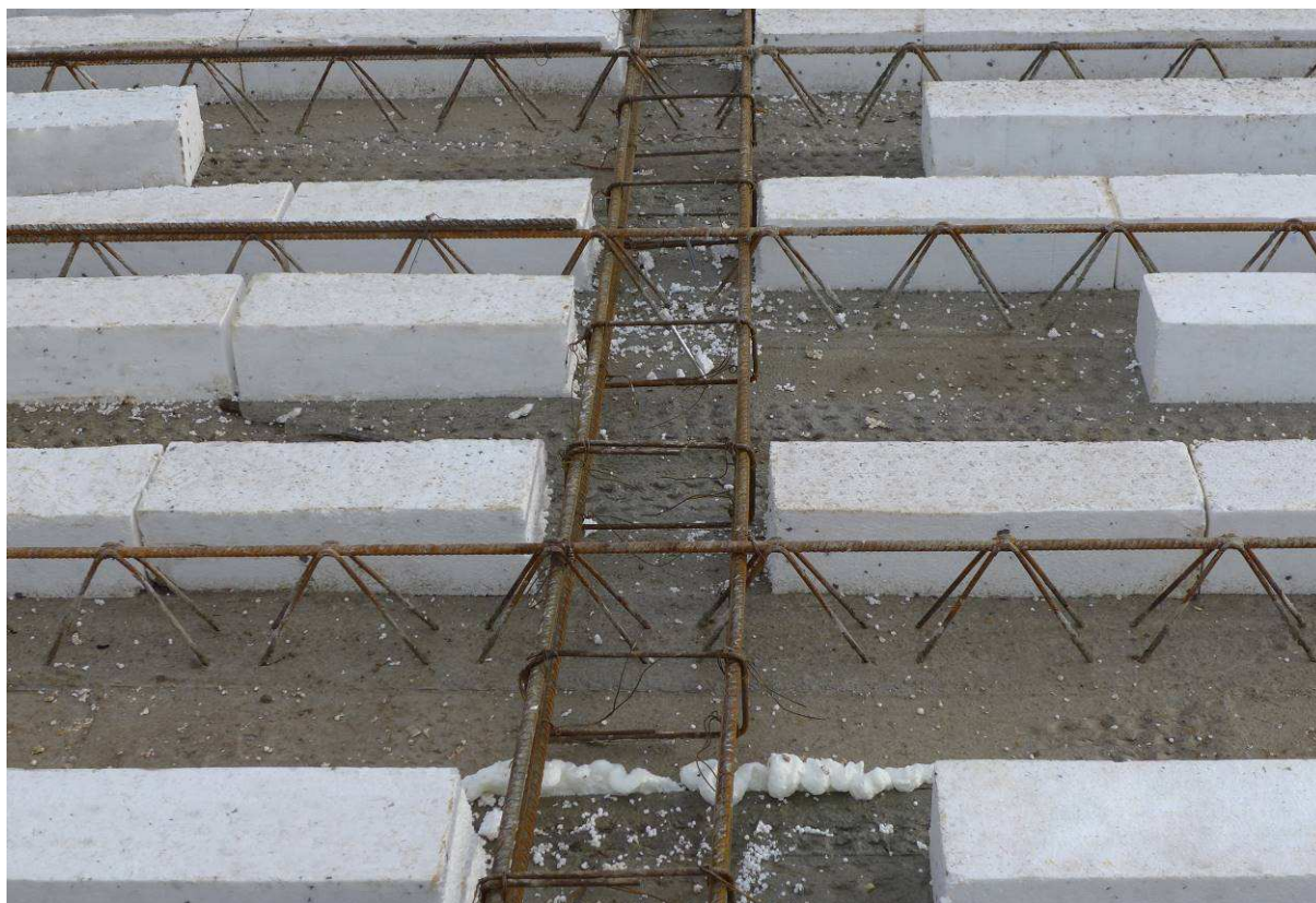
Rys. 50. Belka ukryta w wysokości stropu Fig. 50. The beam hidden in the ceiling height
