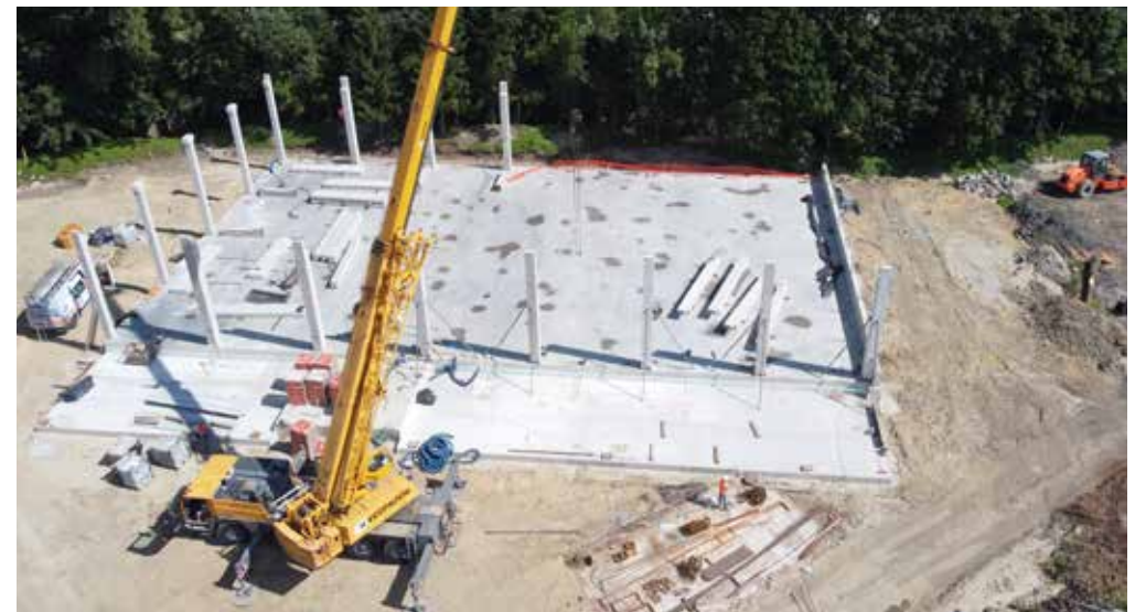
Montaż podwalin i słupów prefabrykowanych pod budowę hali w Jordanowie
