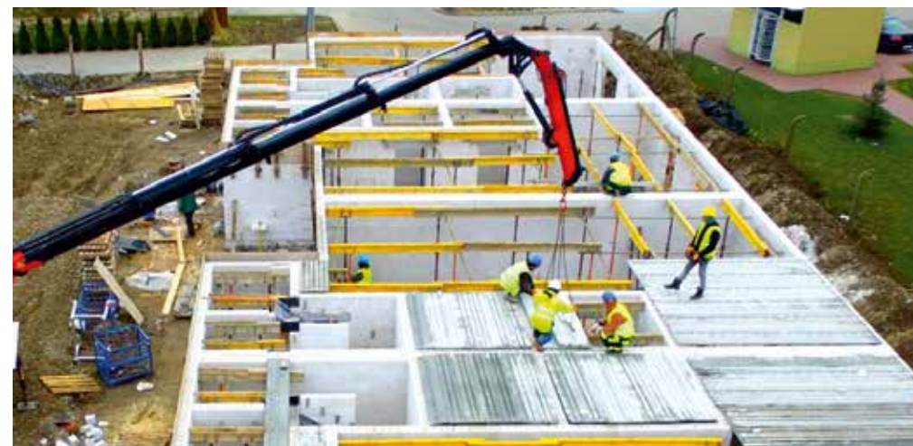
Montaż stropu filigranowego
