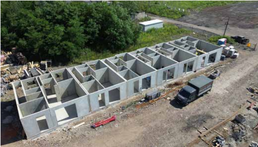
Budynek szeregowy stawiany ze ścian prefabrykowanych
