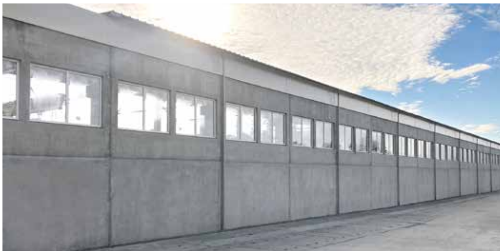
Hala produkcyjna zbudowana ze ścian trójwarstwowych
