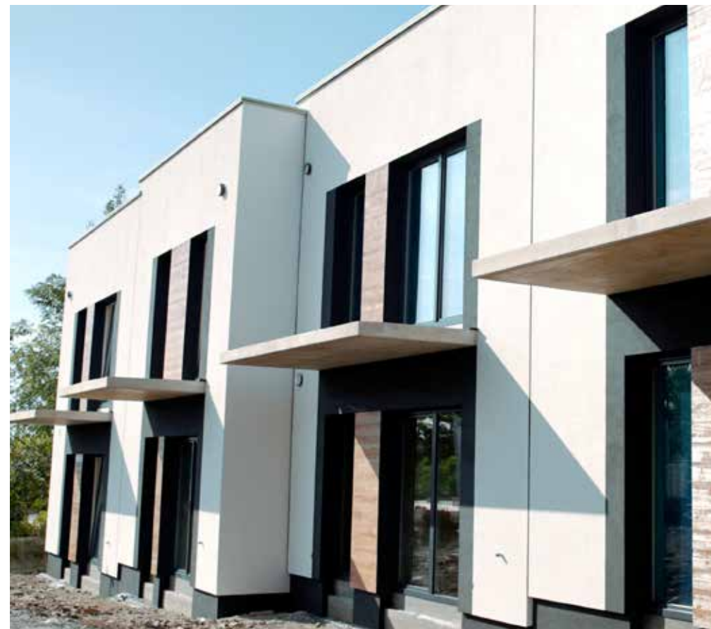
Zamontowane balkony prefabrykowane z łącznikiem termoizolacyjnym
