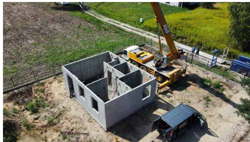
Montaż ścian prefabrykowanych za pomocą dźwigu
