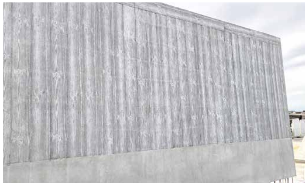
Ściana trójwarstwowa z fakturą
