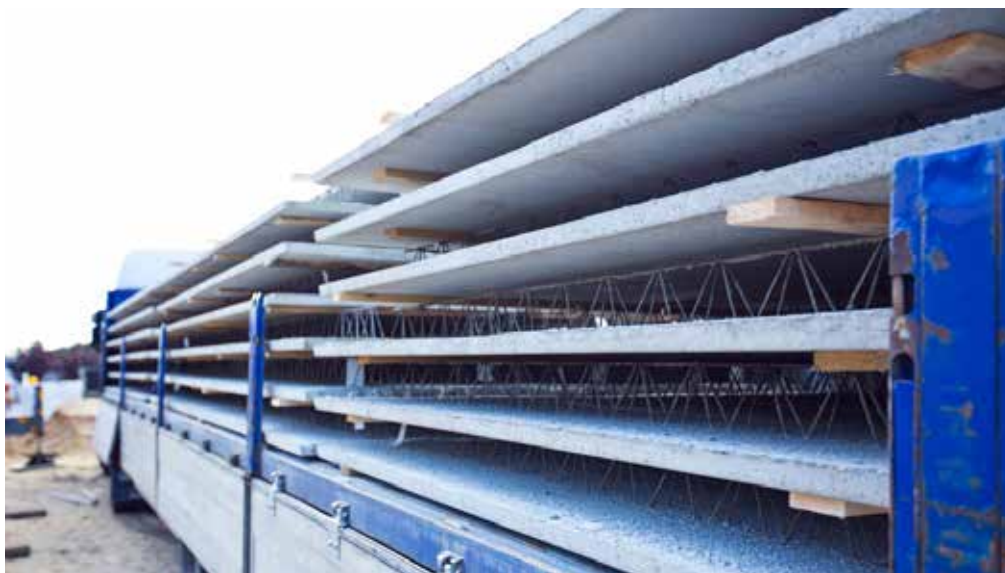
Transport płyt stropowych
