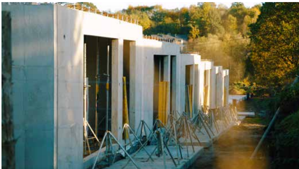
Realizacja inwestycji w zabudowie szeregowej
