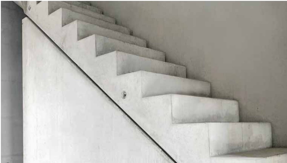
Schody prefabrykowane w inwestycji o zabudowie szeregowej
