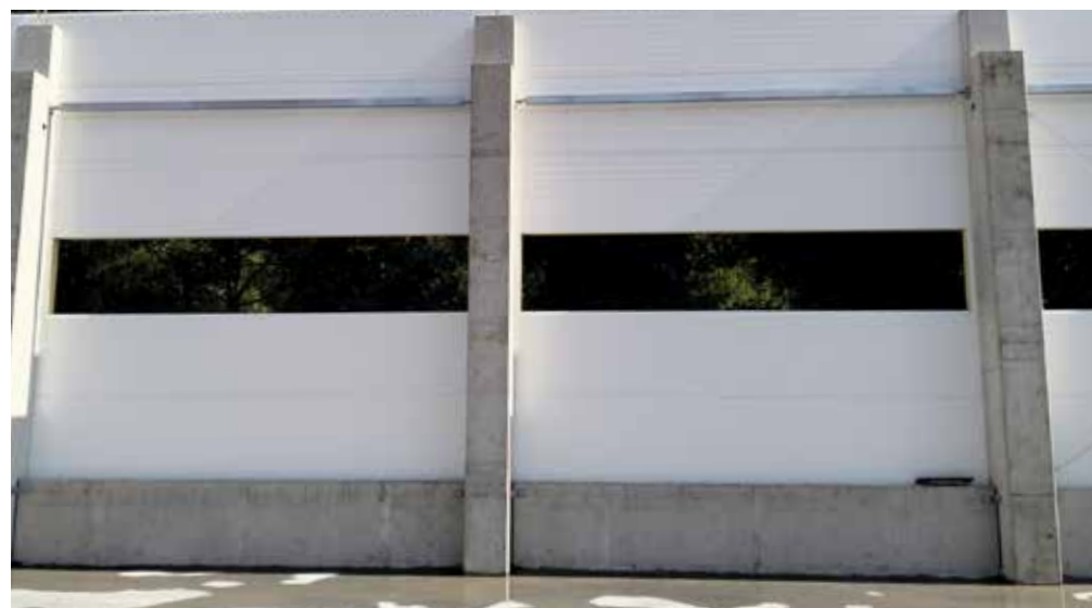
Podwaliny prefabrykowane zastosowane do budowy hali produkcyjnej
