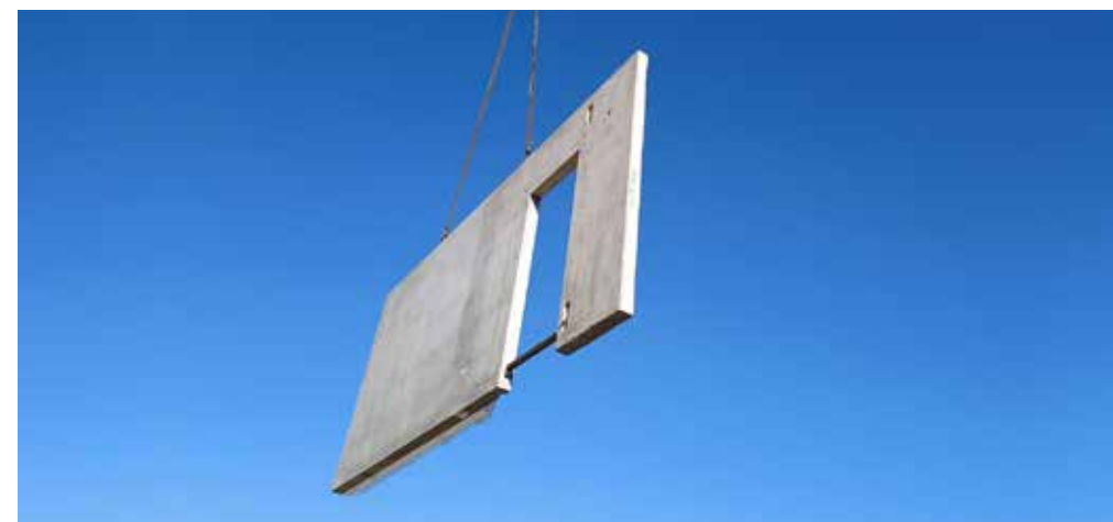
Ściana montowana na budowie za pomocą dźwigu
