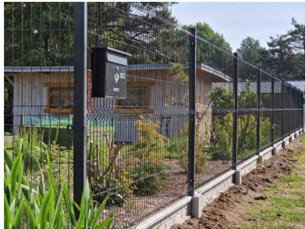
Ogrodzenie postawione z wykorzystaniem podmurówek prefabrykowanych
