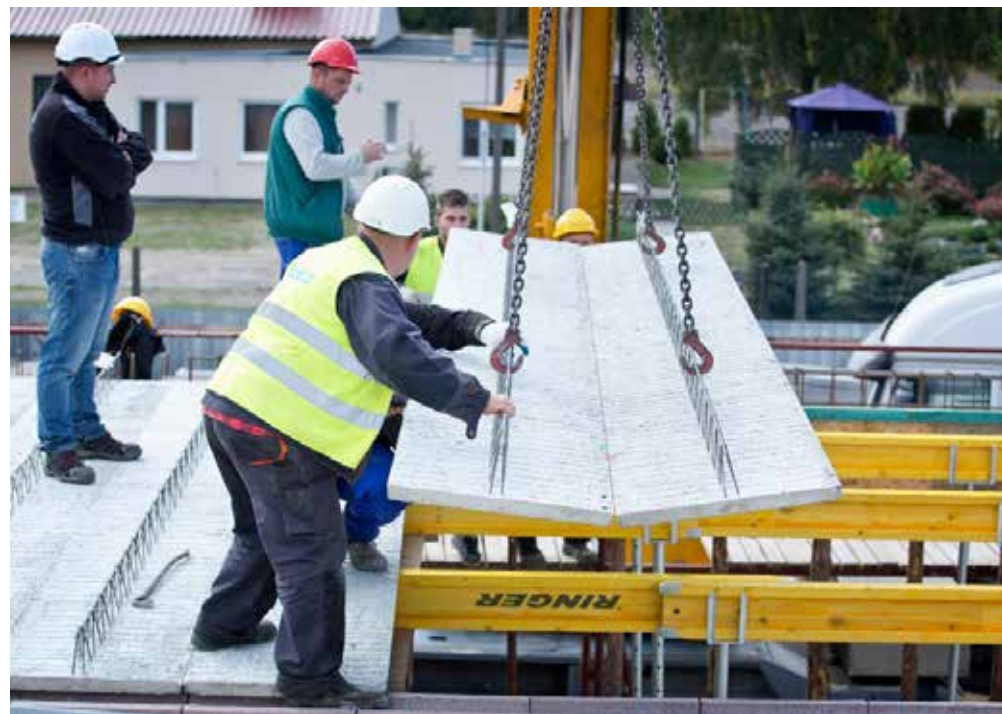
Montaż stropu Vector
